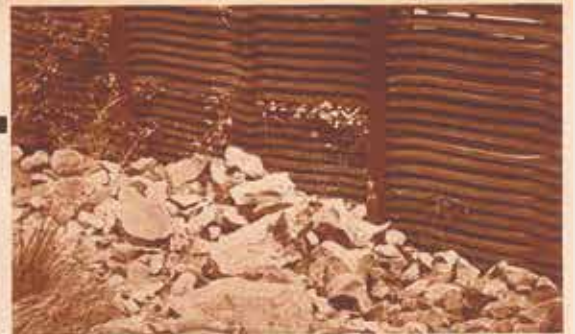
Verwittertes, abbrüchelndes Gestein gefährdet die Bahnanlage. Deshalb ist dort, wo die Schienen sich hart am Felsen entlang ziehen, mitunter ein dreifacher Wall eiserner Schutzwände errichtet worden, der stürzende Steinmassen auffangen soll.
